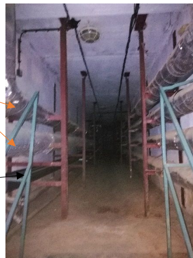
Chodba pod druhým stupněm – vstup
