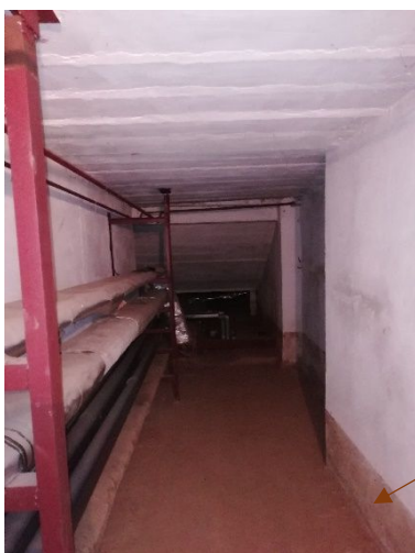
Chodba pod schody u jídelny
